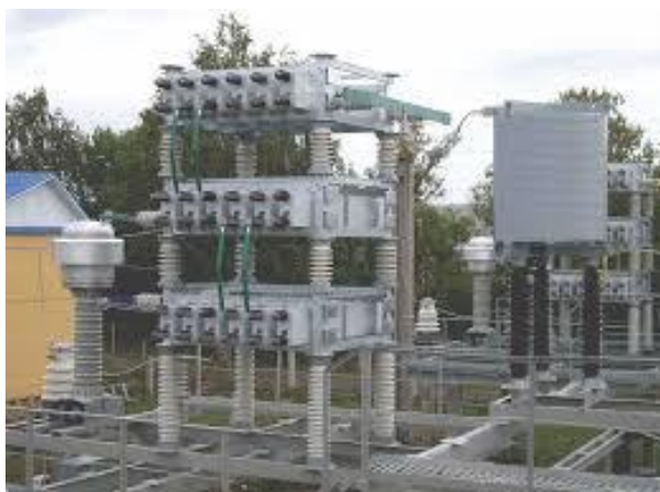
4.6–сурет – «Өскемен конденсатор зауыты» ЖШС статикалық конденсаторлардың батареялары
