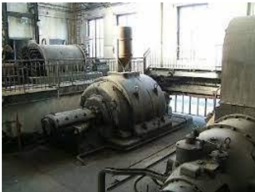
4.4– сурет – Синхронды компенсатор
